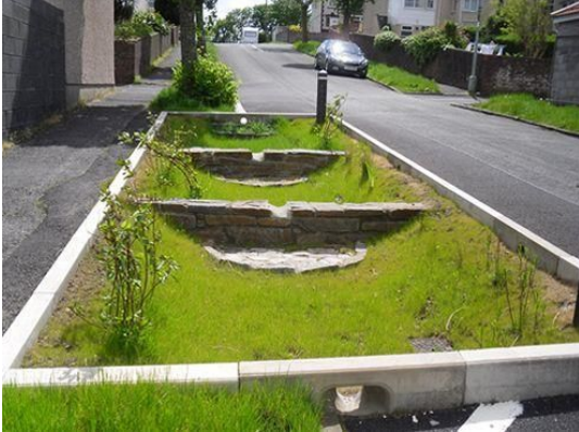
Bild 13. Damm. (12) Bild 14. Tillfällig uppdamning av dagvatten på speciellt anlagda översvämningssytor. (11)
