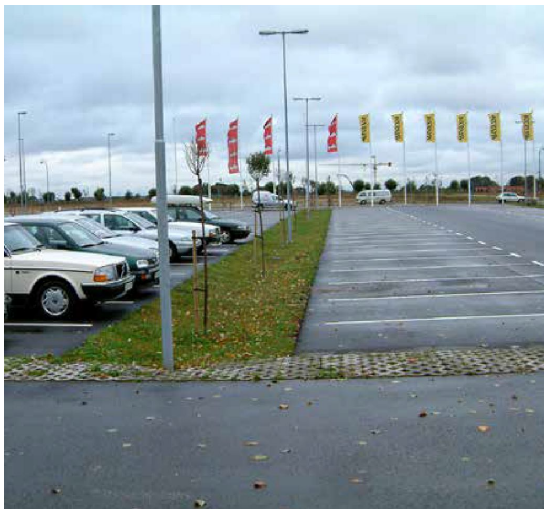
Bild 10. Infiltration på gräsytor. (9)
