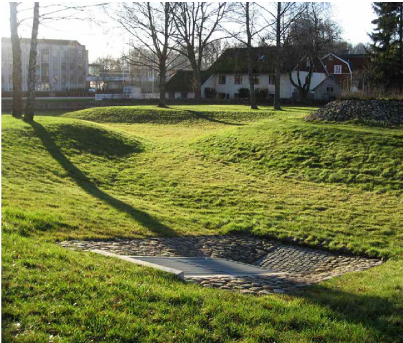
Bild 12. Tillfällig uppdamning av dagvatten på speciellt anlagda översvämningssytor. (9)
