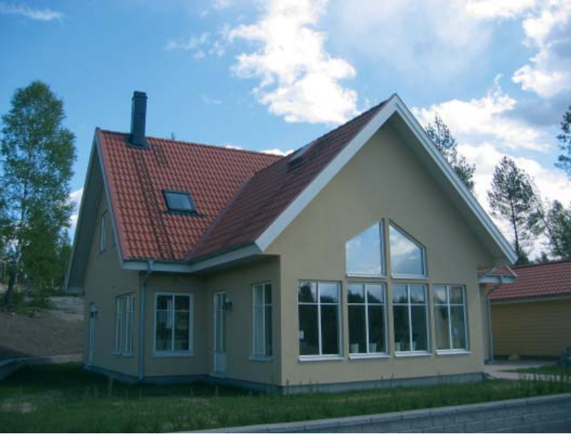
undersida taksprång och vindskivor målas vita
