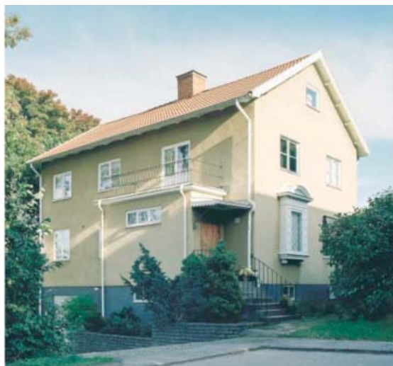
Nätt takfot med synliga tassar
