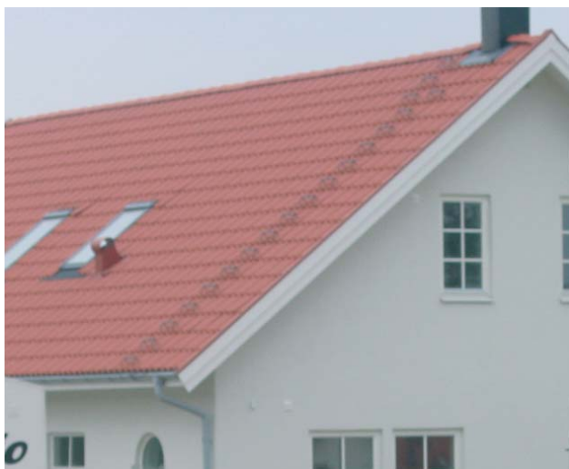
Hus med öppen takfot
